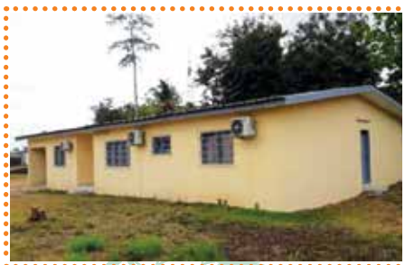
Vue extérieure du bureau de Grand-Lahou réhabilité
