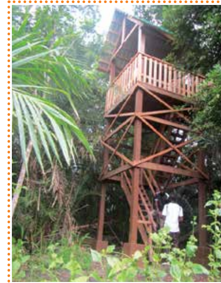
Mirador du relais ségui du Parc national d'Azagny réhabilité
