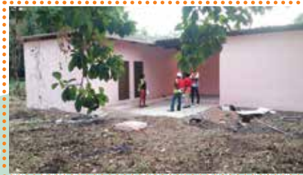
Vue de la base-vie de Nzida réhabilité
