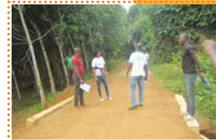
Point critique aménagé sur 13 km de la piste périmétrale au nord du Parc national d'Azagny
