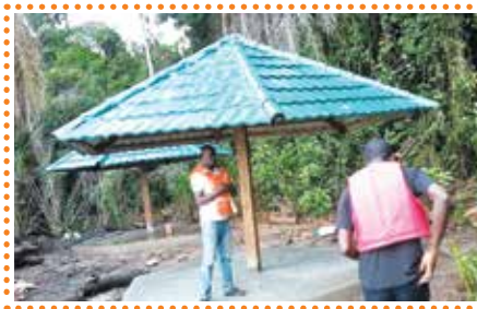
Construction d'aire de pique-nique au relais Ségui du PnA
